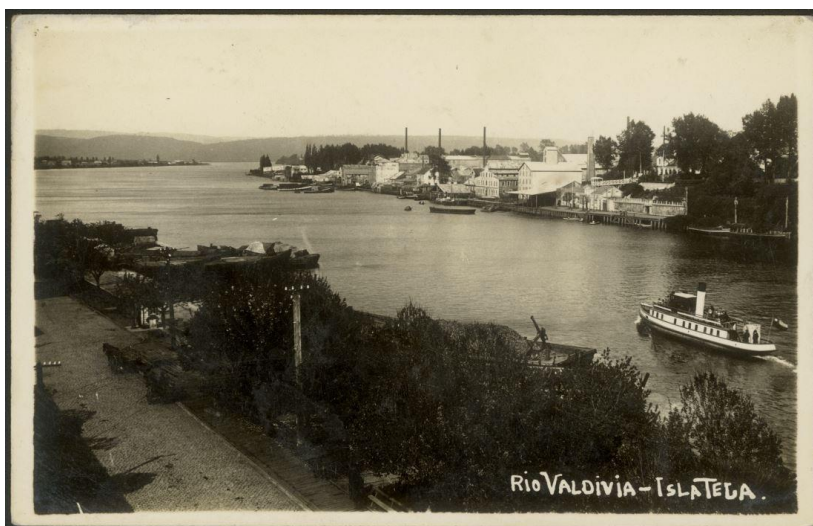
FOTO 1 — PASADO (ANTES del terremoto)
